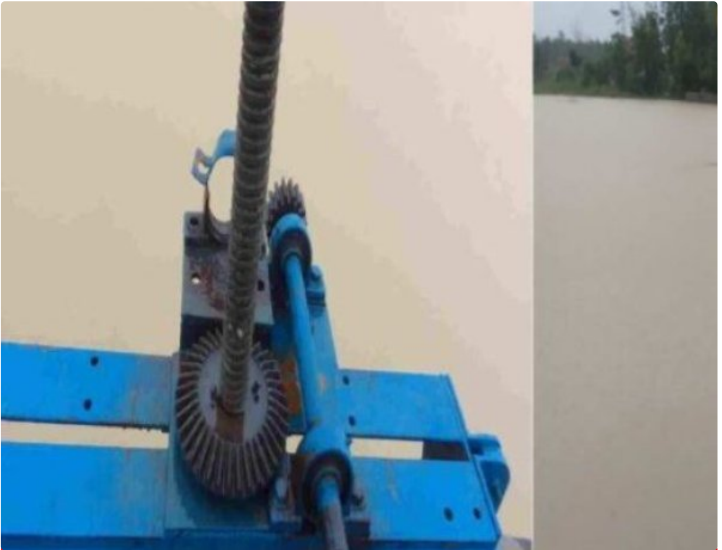
Pintu air Albaret Simpang Mesuji
